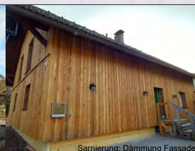
Sarnierung: Dämmung Fassade
